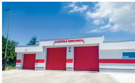
Obnovená hasičská zbrojnica
