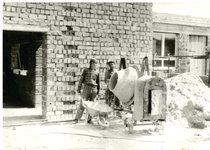
Výstavba KD 1971, archív Blažo
