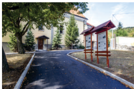
Nový asfaltový koberec Na strane 1,2
