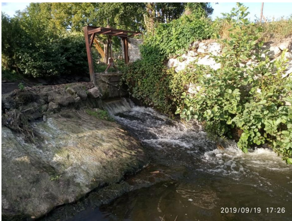
Obr.č.4 : Súčasný stav hrádze a stavidiel
