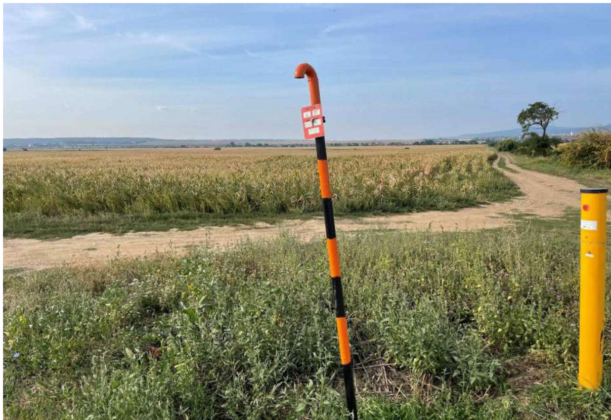
Obr. č. 30: VTL prípojka DN80
