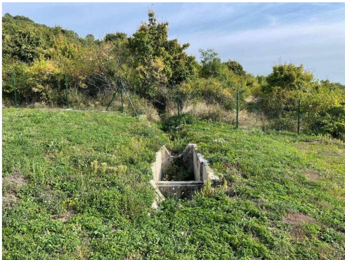
Obr. č. 17: Odvodňovací kanál OK-1
