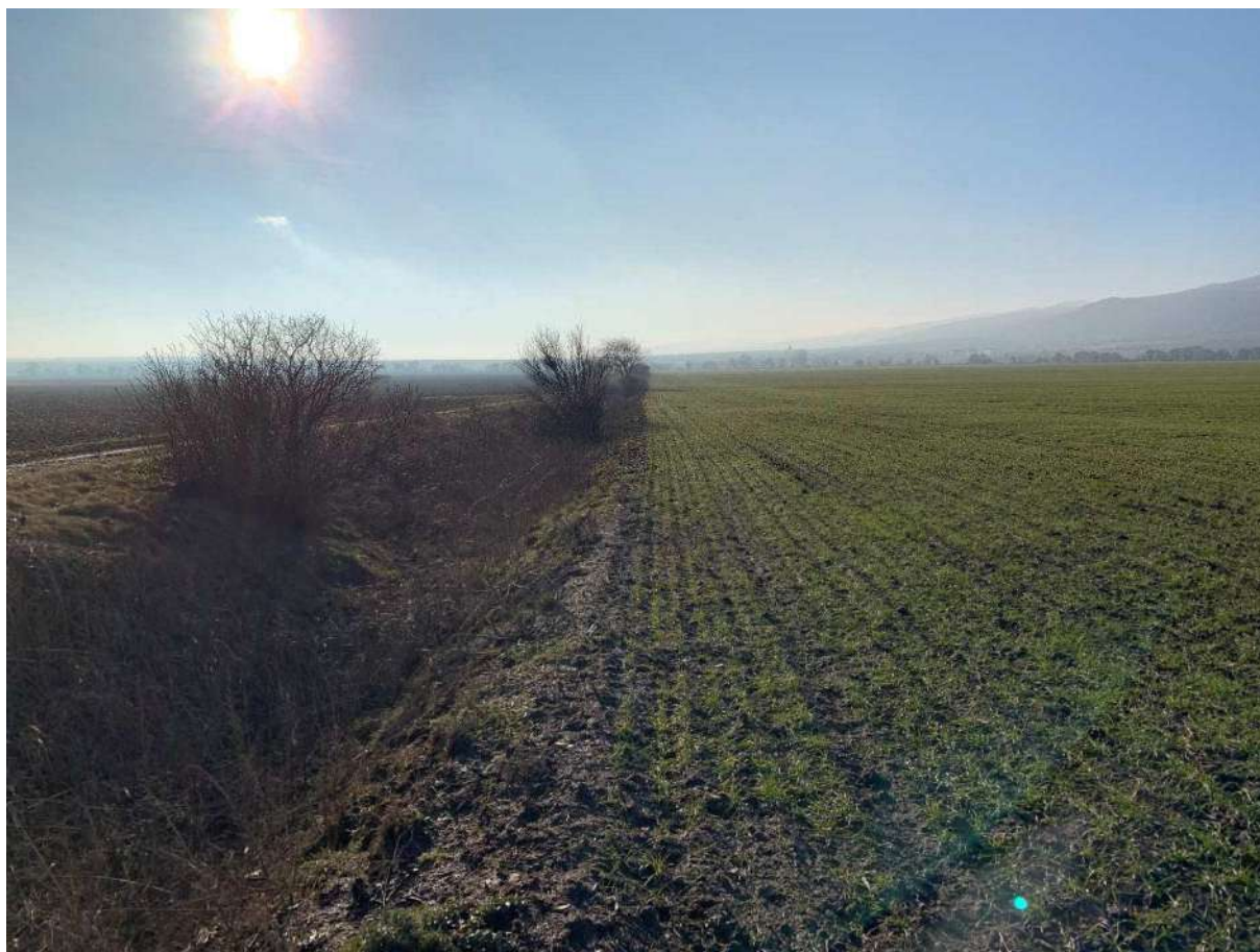
Obr. č. 18: Odvodňovací kanál OK-2
