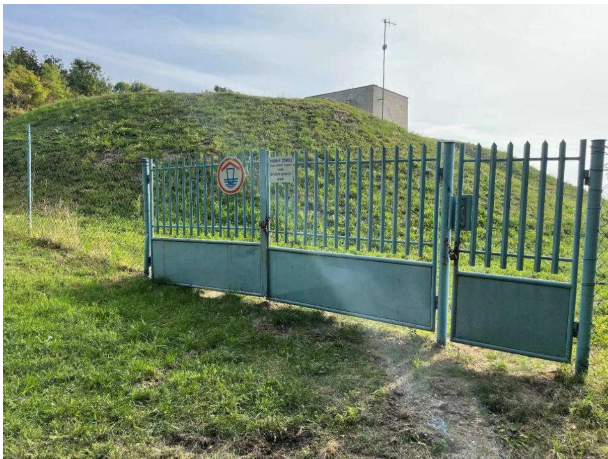
Obr. č. 23: Zemný vodojem
