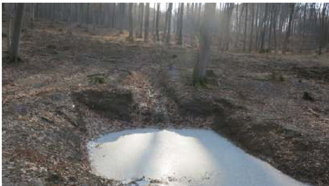
Obr. 9. Príklad zasakávacej jamy pod lesnou cestou v Skalici
