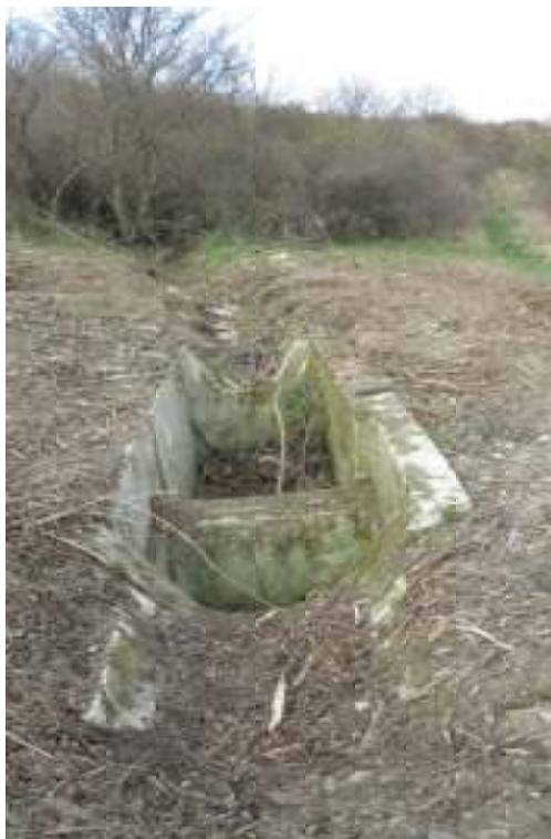
Obr. č. 11. Koniec starého zberného kanála so sedimentačnou šachtou
