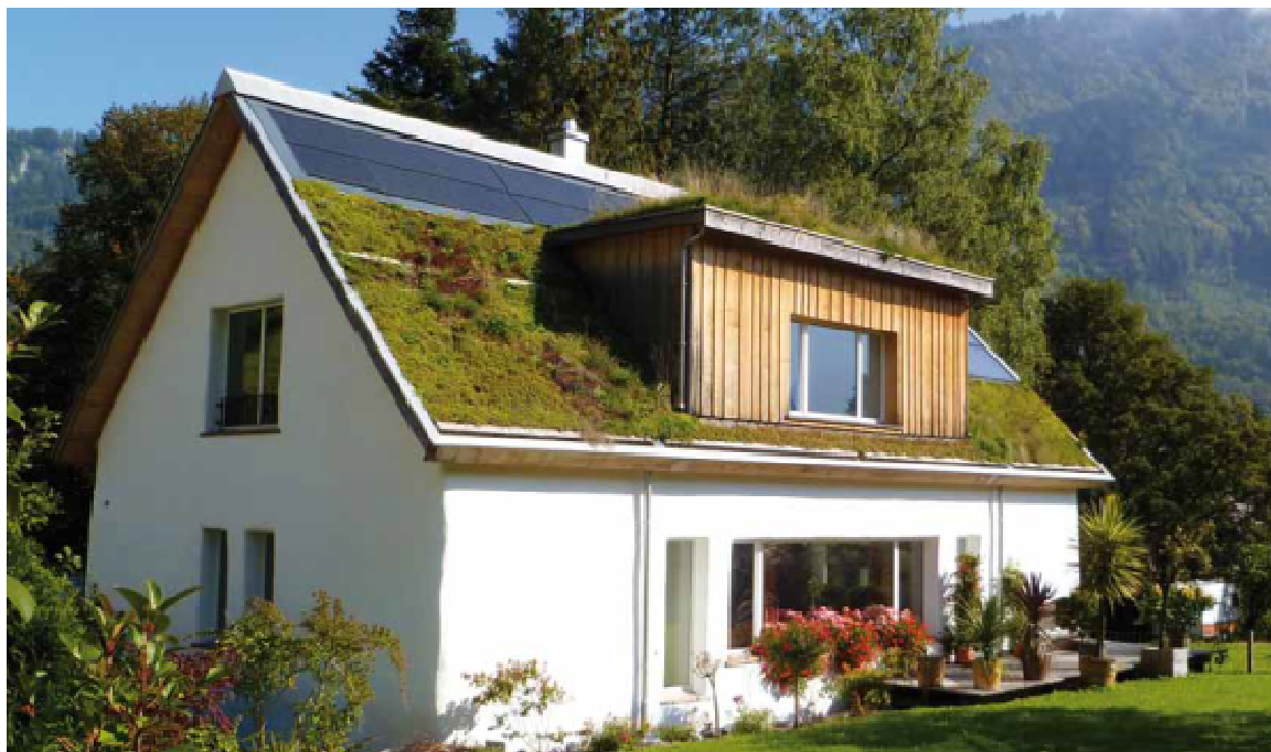
Obr. č. 19. Vegetačná šikmá sedlová strecha (Zinco+Manadatrading) s Fotovoltaickými el. panelmi a podzemnou nádržou na akumuláciu dažďovej vody je optimálne usporiadanie novej výstavby v Horných Orešanoch.
