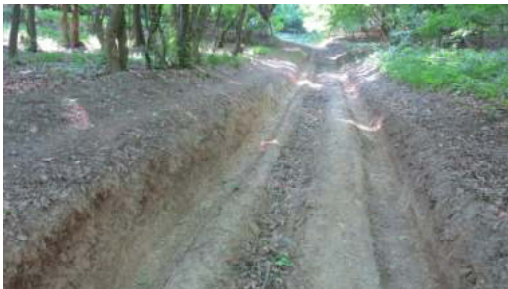
Obr. č. 3. Lesné približovacie cesty po spádnici spôsobujú eróziu pôdy a zrýchľujú povrchový odtok a preto je potrebné ich prebudovať.
